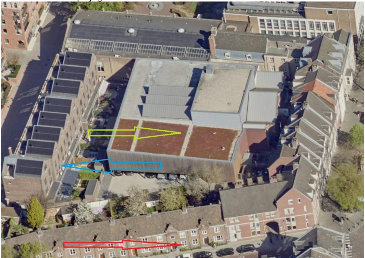
Afbeelding: Boschstraat 30 achterzijde (groene pijl) met aan de zuidzijde daarvan de woningen Achter de Barakken 8 en 10 (indicatief aangegeven met rode pijl) van aanvragers.
